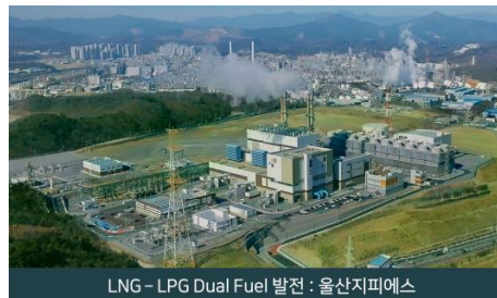
LNG - LPG Dual Fuel 발전 : 울산지피에스
